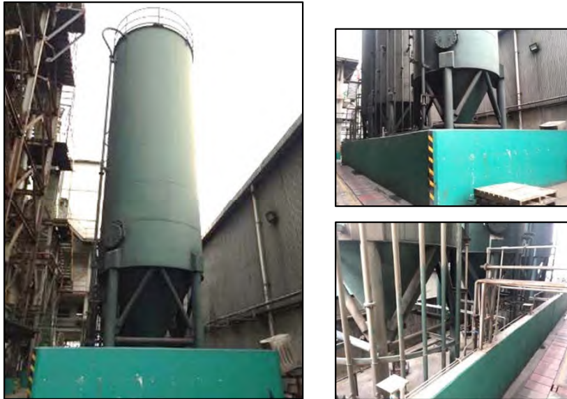
รูปที่ 6 แทงค์รวบรวมน้ำเสียไม่อันตราย (Non-hazardous liquid waste storage tank) ขนาด 125 ลูกบาศก์เมตร ในปัจจุบัน มีจำนวน 3 แทงค์
